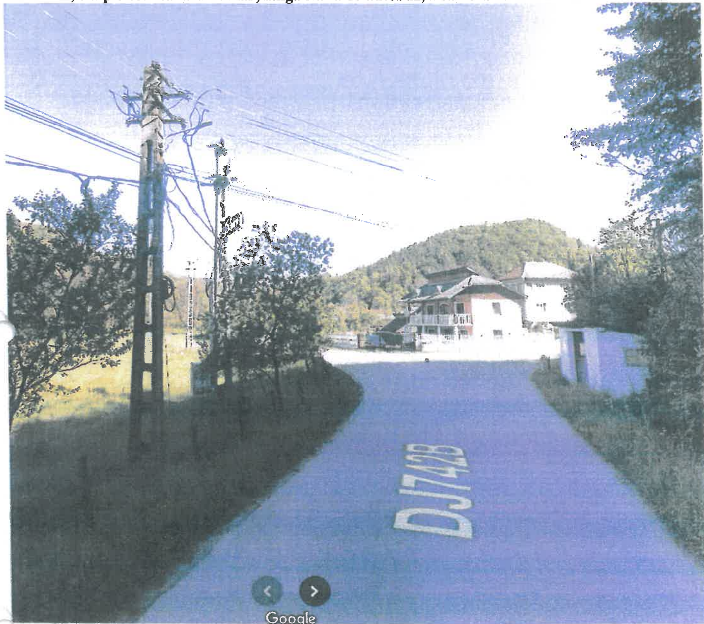
Punctul B, stalp electrica fara numar, langa statia de autobuz, 1 camera LPR si 2 camere ansamblu
