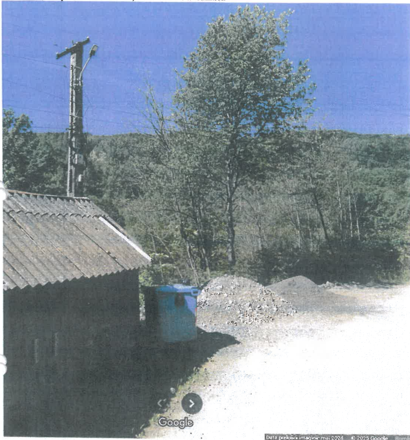
Punctul N, stalp Electrica nr. 23 , 2 camere de ansamblu
