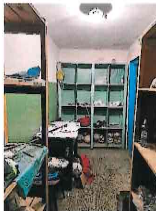
Încăperea C2-P09 – Spațiu depozitare
