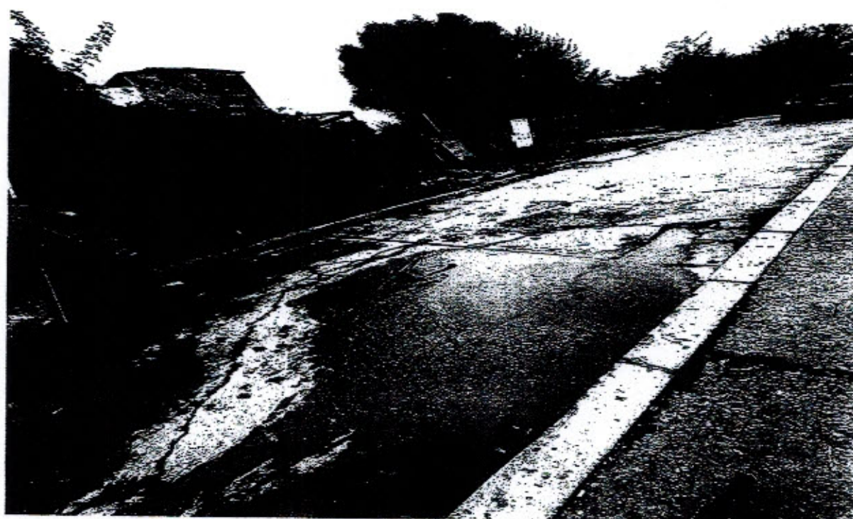
Figura 3.4. Strada nr.3, betonată, gropi, fisuri ale dalelor
