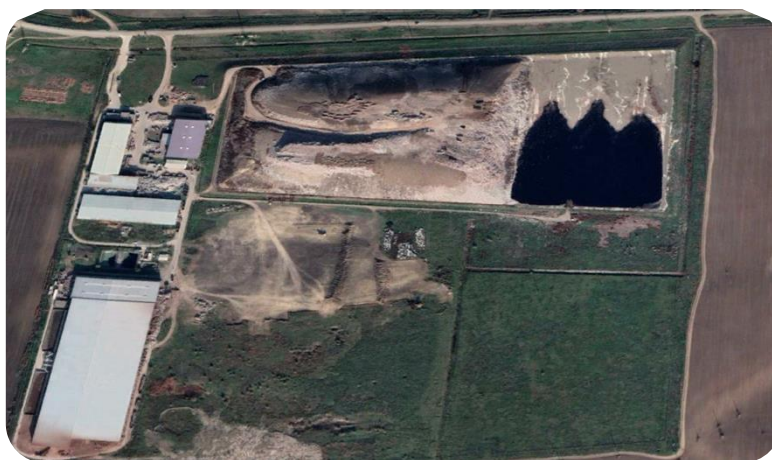
Figura 4-4 Depozitul de deșeuri municipale Țuțora
