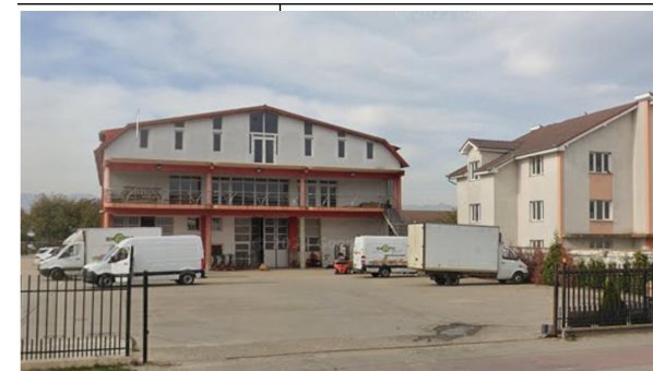
Perspectivă existentă din zona str. A.I. CUZA
