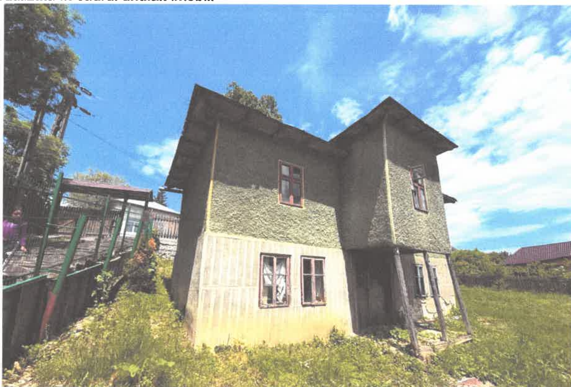
Vedere a fațadei sudice a locuinței C1 – situație existentă
