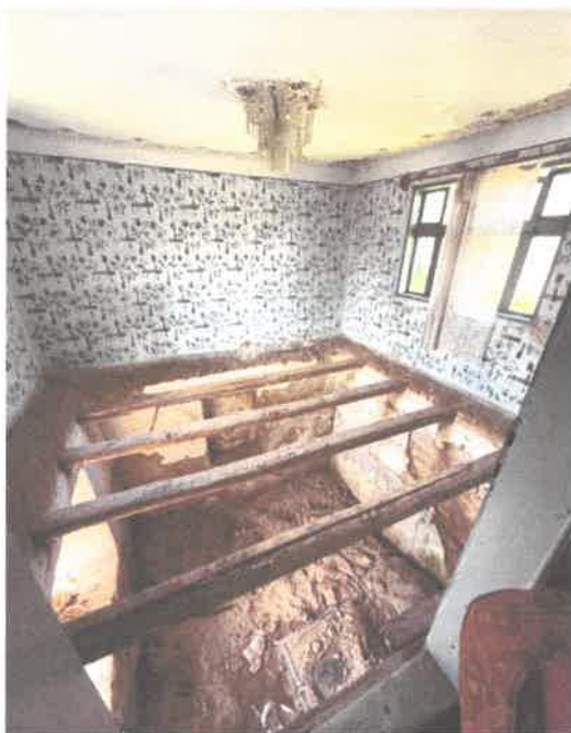
Camera amplasată pe lateralul vestic – nivelul parterului
