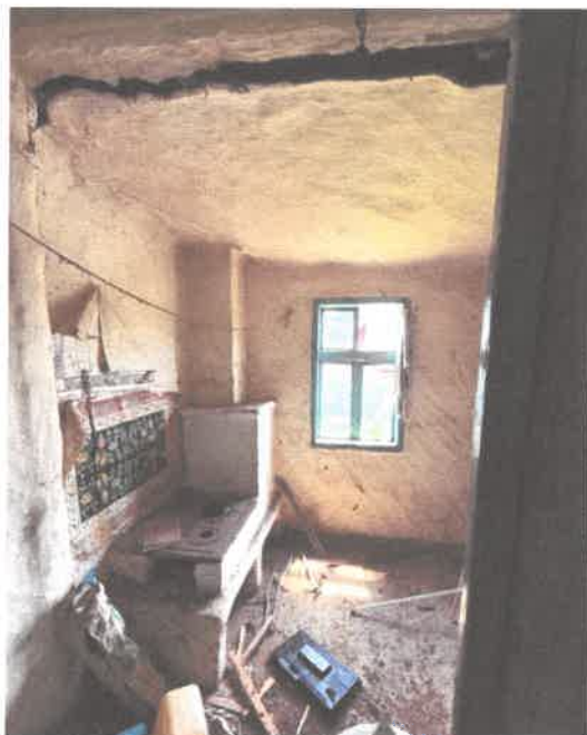
Camera amplasată la capatul coridorului (bucătărie)
