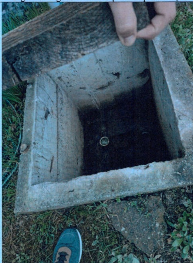
Figura 17. Căminul de apometru din curte – apa este la 0,5-0,6 m față de CTN
