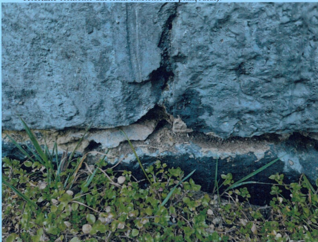
Figura 6. Zidăria din piatră a fundației – imagine de la soclu
