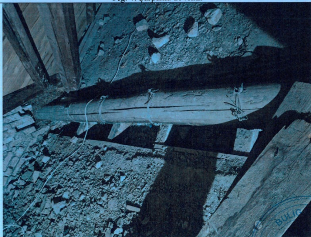
Fig. 5. Mod de reparare a planșeului (s-a înlocuit o grindă)
