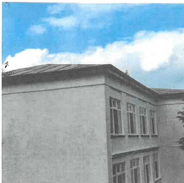
Acoperis - tip sarpanta de lemn cu invelitoare de tabla
