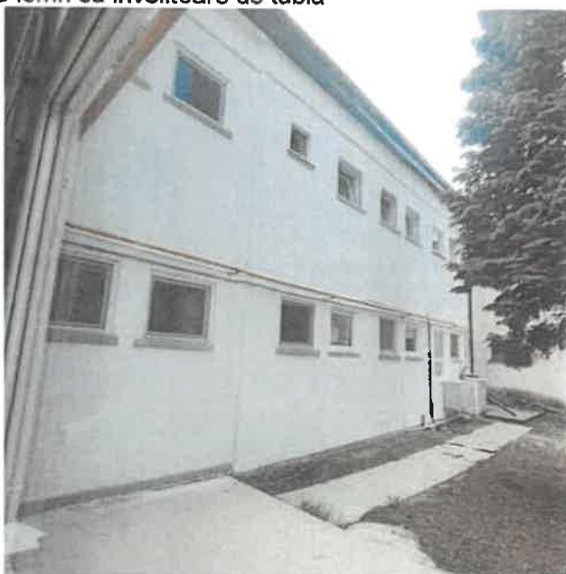
Tencuieli exterioare cu terasit
