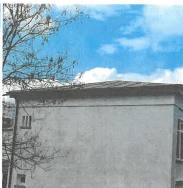
Acoperis - tip sarpanta de lemn cu invelitoare de tabla
