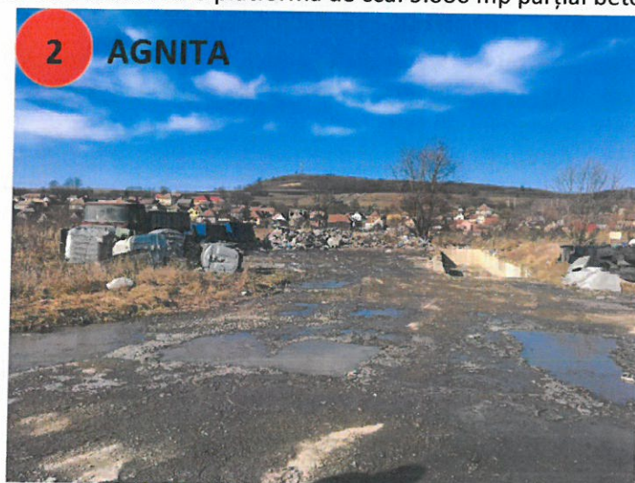
Figură 2-10 - Stația de transfer Agnita
