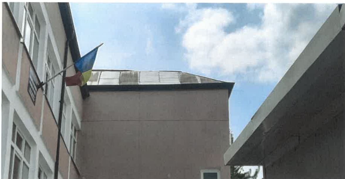
Acoperis - tip sarpanata de lemn cu invelitoare de tabla
