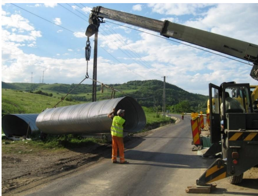
[fig. 5] Transportul și descărcarea structurilor metalice.
