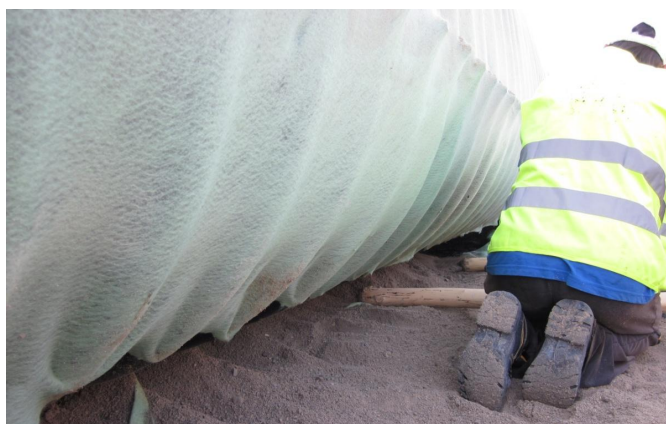
[fig. 12] Compactarea manuală cu maiul.
