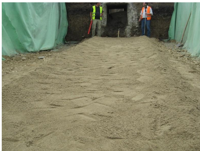
[fig. 1] Modelarea stratului talpa dupa forma structurii metalice.
