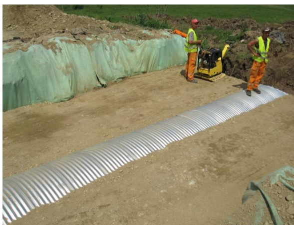
[fig. 2] Umplutură realizată concomitent pentru ambele părți ale structurii.
