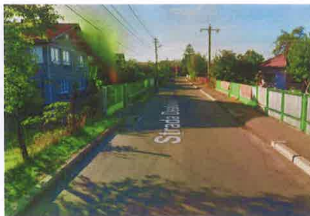
Str. Dealului, trotuar subdimensionat pe latura sudică
