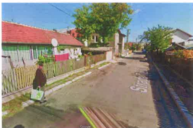
Str. Țițeiului: trotuar subdimensionat pe latura nordică
