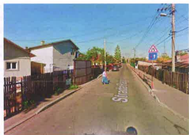
Cartierul Turnătorie, str. Păcurii: trotuar subdimensionat pe latura nord-vestică
