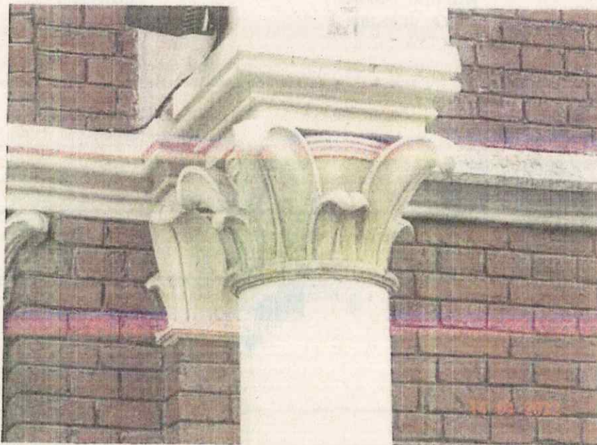
Acces principal,coloana cu capitel ornamentat: depuneri de saruri cu aspect albicios si cruste negre.
