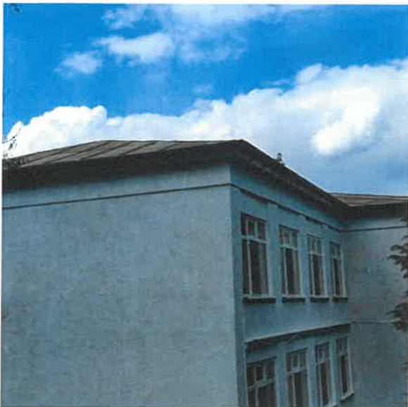
Acoperis - tip sarpana de lemn cu invelitoare de tabla
