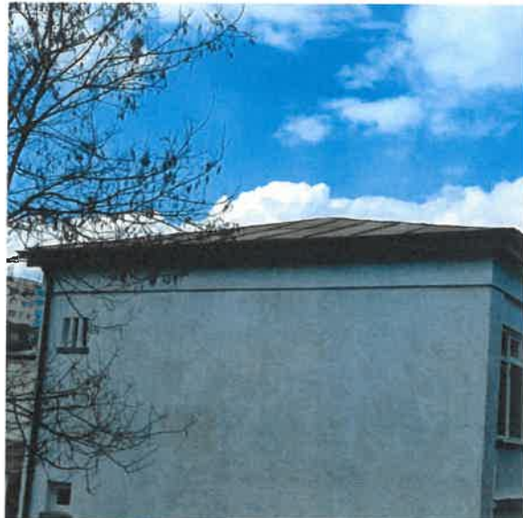
Acoperis - tip sarpana de lemn cu invelitoare de tabla
