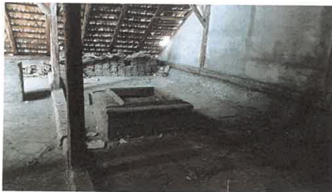
Ziduri frontoane - lipsa centuri si stalpisor de confinare
