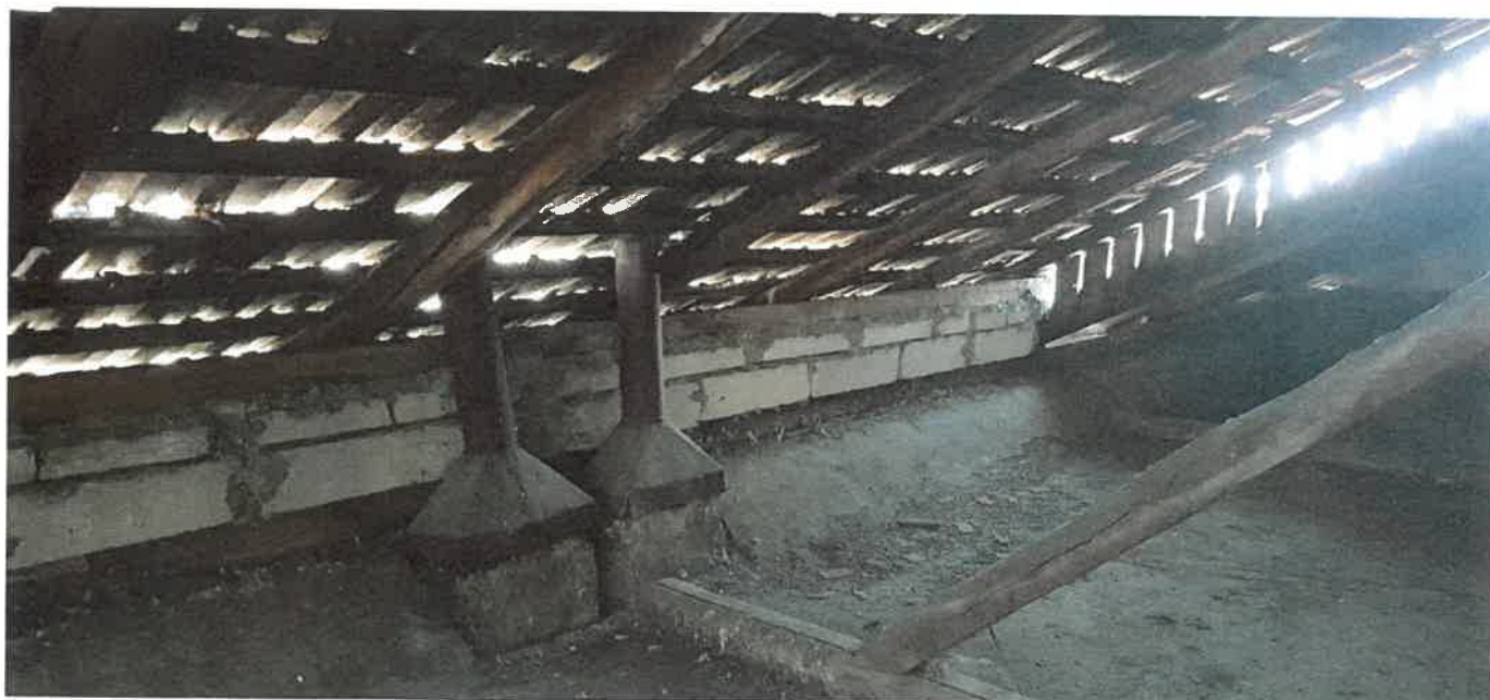
Zidarie atic – necorespunzatoare + crapaturi longitudinale capriori
