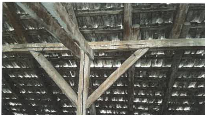
Pop si pana longitudinala – crapaturi longitudinale + noduri nesolidarizate
