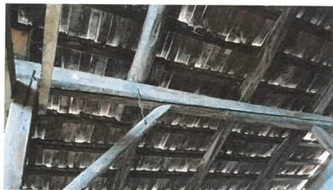
Pop si pana longitudinala – crapaturi longitudinale + noduri nesolidarizate
