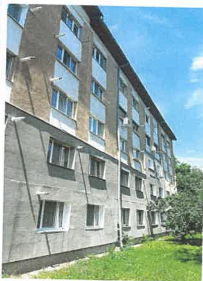
Fatada principala termoizolatii existente
