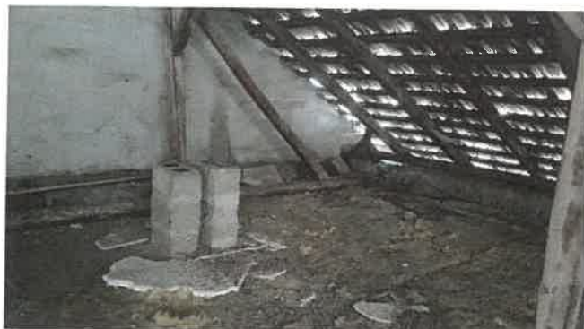
Ziduri frontoane - lipsa centuri si stalpisor de confinare
