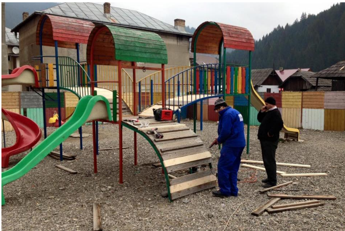
Foto: Loc de joacă pentru copii, foto făcută în timpul efectuării lucrărilor de reparații
