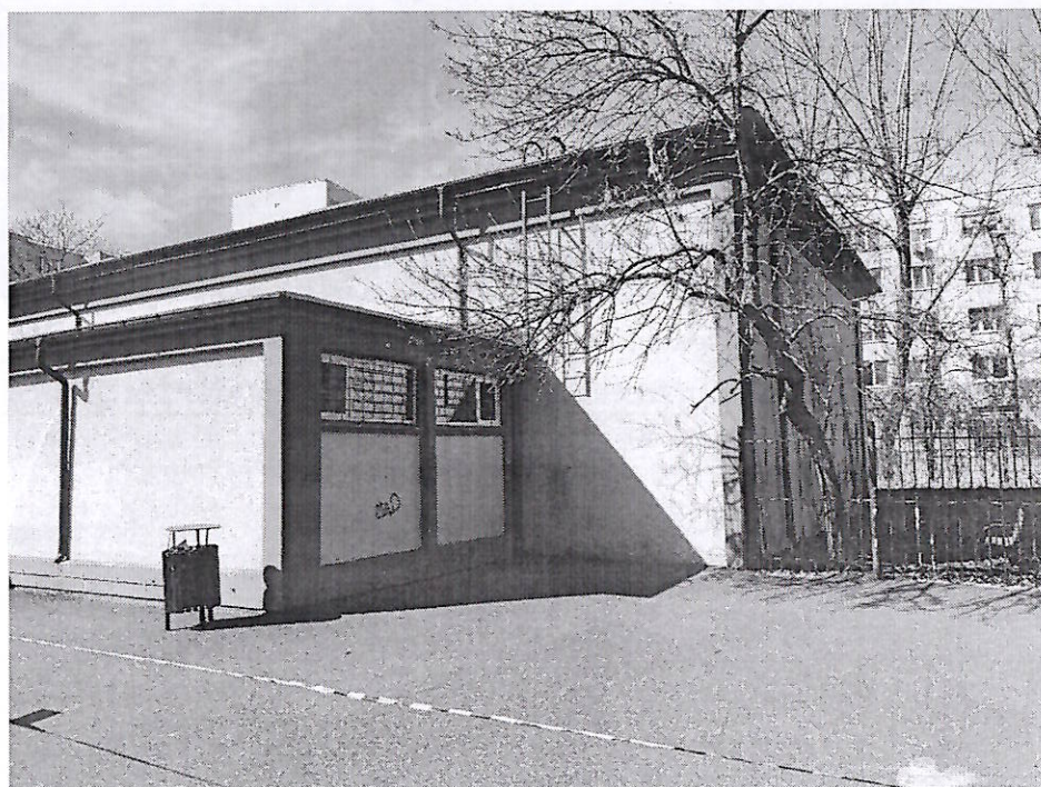
Fig. 3: Vedere colț sud est sală de sport
