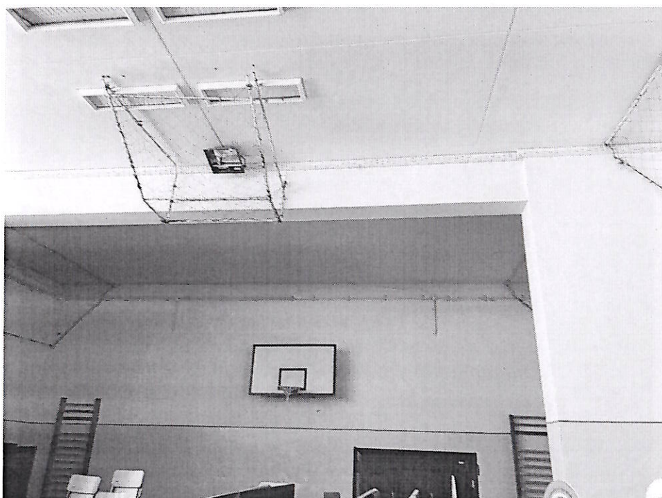
Fig. 5: Vedere interioară perete dinspre est
