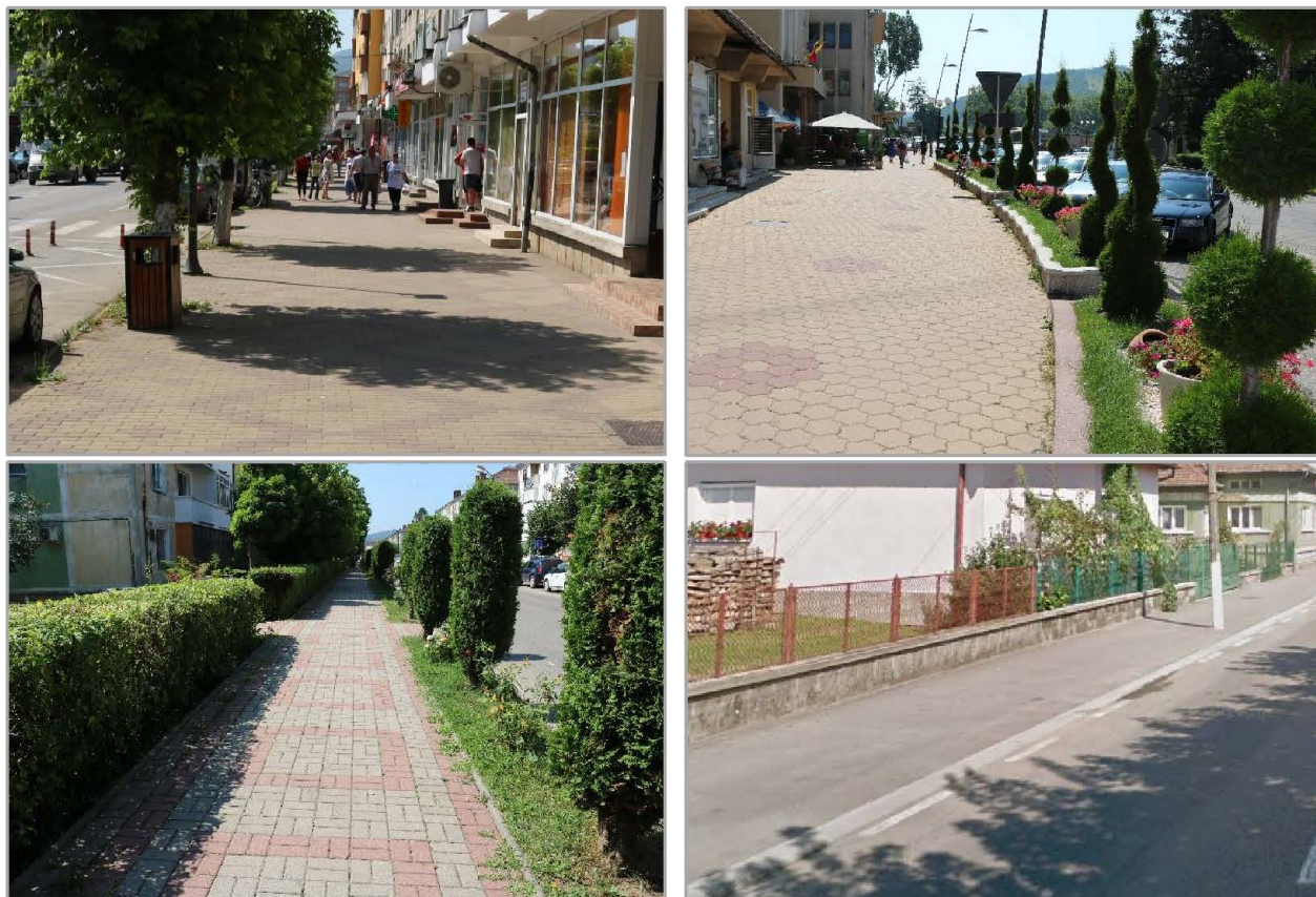
Figura 2.45. Trotuare în stare bună (Exemplificare).
