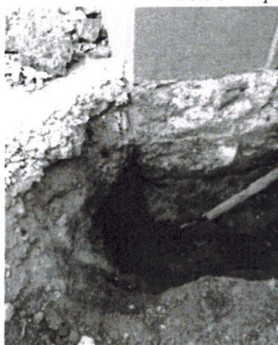
Foto 4 – Aspecte sistem de fundare – Sondaj
