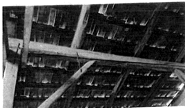
Pop si pana longitudinală – crapaturi longitudinale + noduri nesolidarizate
