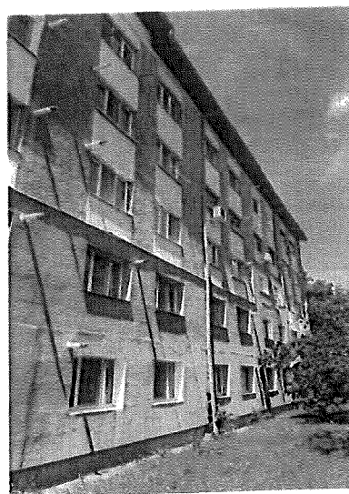
Fatada principala termoizolatii existente
