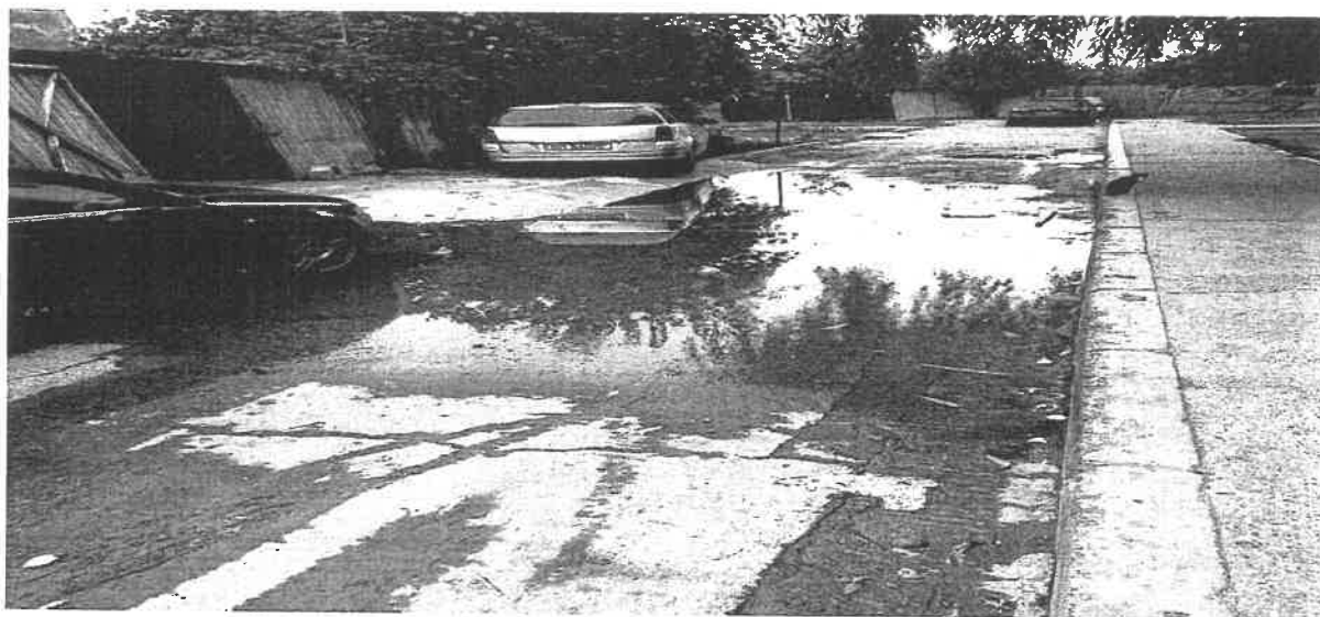
Figura 3.2. Strada nr.3, betonată, punct de inflexiune minin, nu se asigura scurgerea apelor
