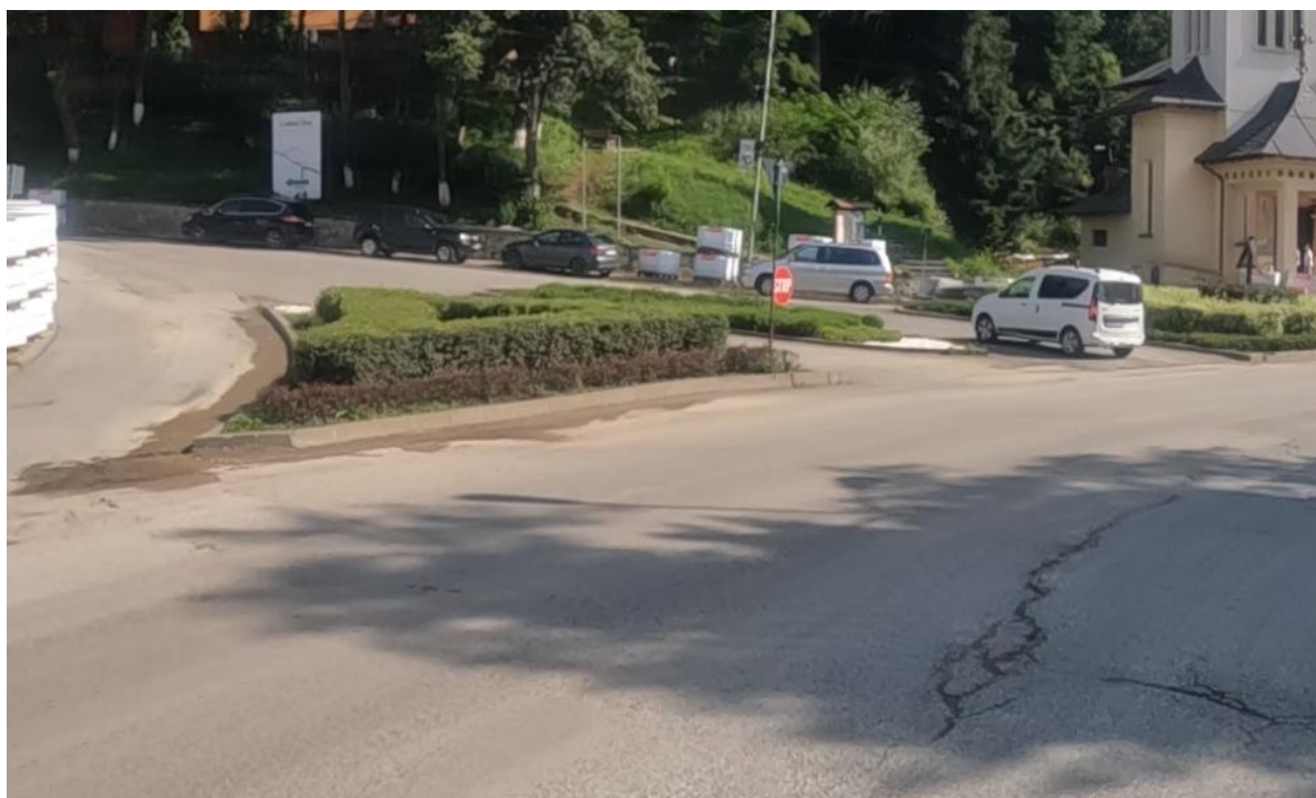
Fig. 32 Intersecția Calea Transilvaniei cu Str. Mihai Eminescu (zona pod peste Dorna).
