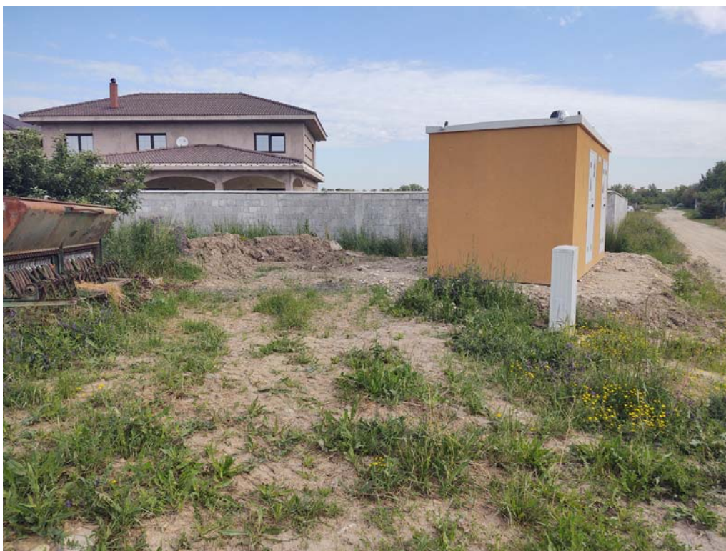
Fig. 14. Imagine cu lucrările de introducere a cablurilor de electricitate care au scos la iveală solul galben steril. Detaliu cu transformatorul electric
