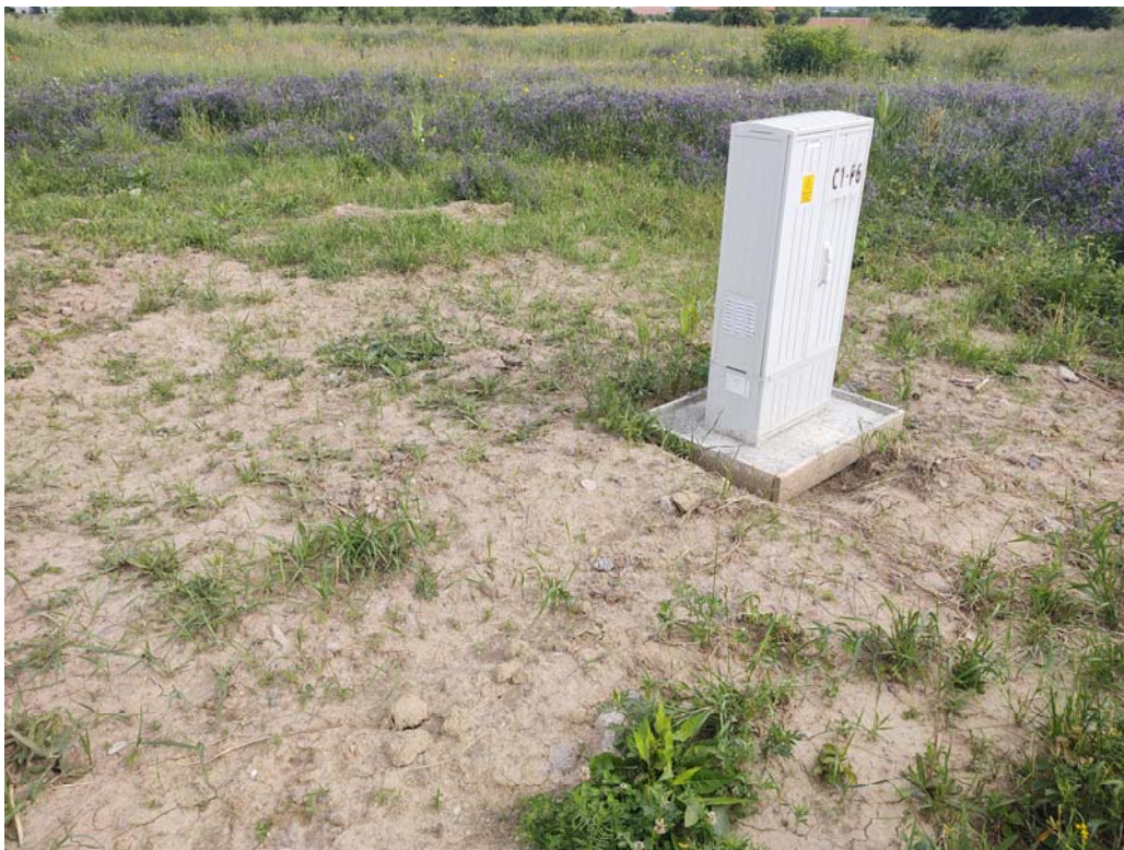
Fig. 13. Imagine cu lucrările de introducere a cablurilor de electricitate care au scos la iveală solul galben steril
