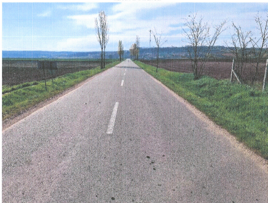
Cale de rulare din mixtură asfaltică, cu lățimi 5,20-5,45m
