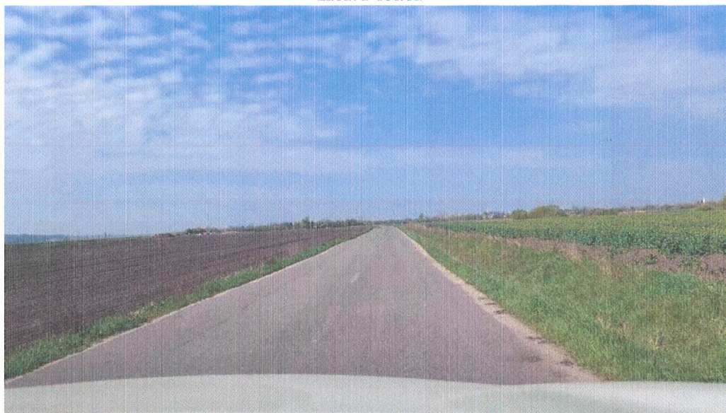
Cale de rulare din mixtură asfaltică, cu lățimi 5,40-5,80m
