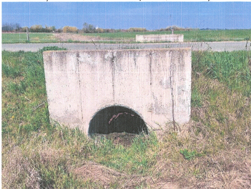
Podeț tubular existent – colmatat
