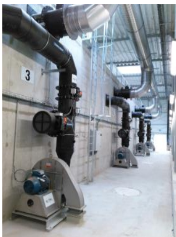
Figură 3-70 Sistem de aerare în zona tehnică
