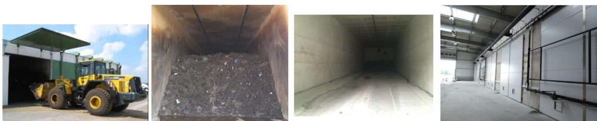
Figură 3-42 SC Șura Mică modernizată – exemplu tunel compostare
