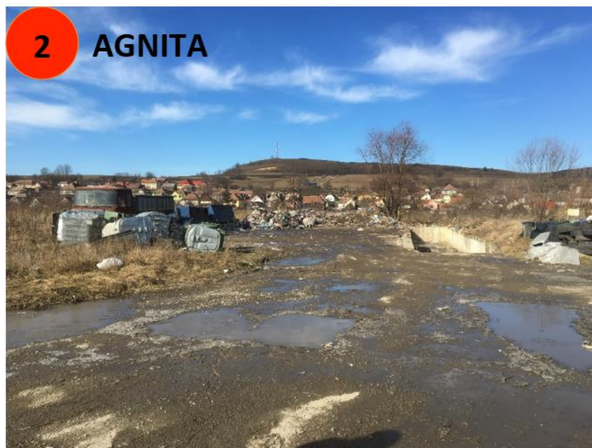
Figură 2-15 - Stația de transfer Agnita
