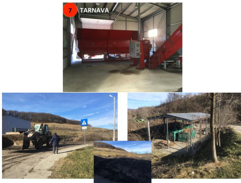
Figură 2-33 - Stația de compostare Târnavă
