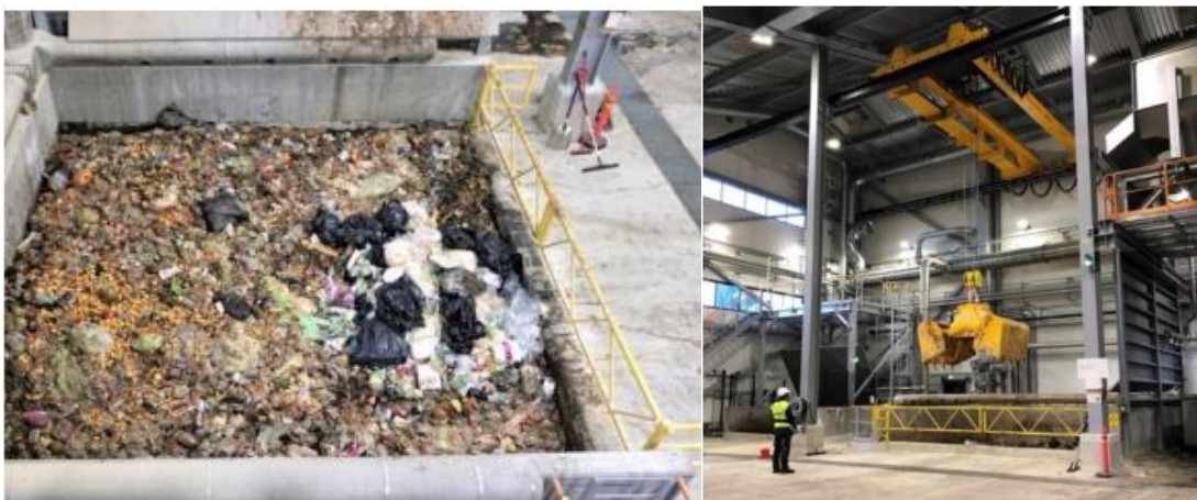
Figură 3-62 Groapa tehnologică de stocare și podul rulant cu greifer
