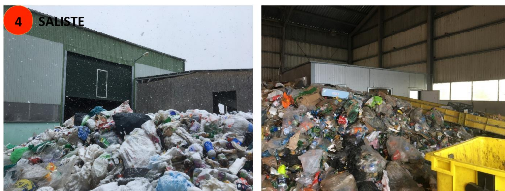
Figură 2-27 - Stația de sortare Săliște
