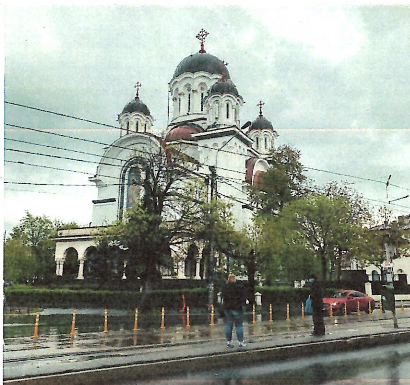
Vedere dinspre latura sud-vestică a Bisericii
