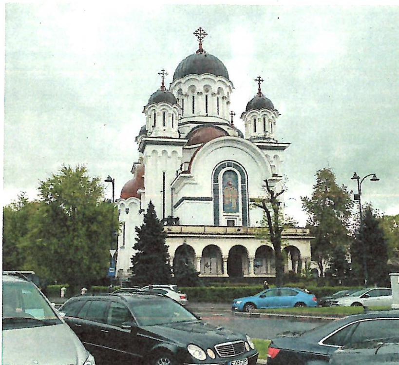
Vedere dinspre latura vestică a Bisericii
