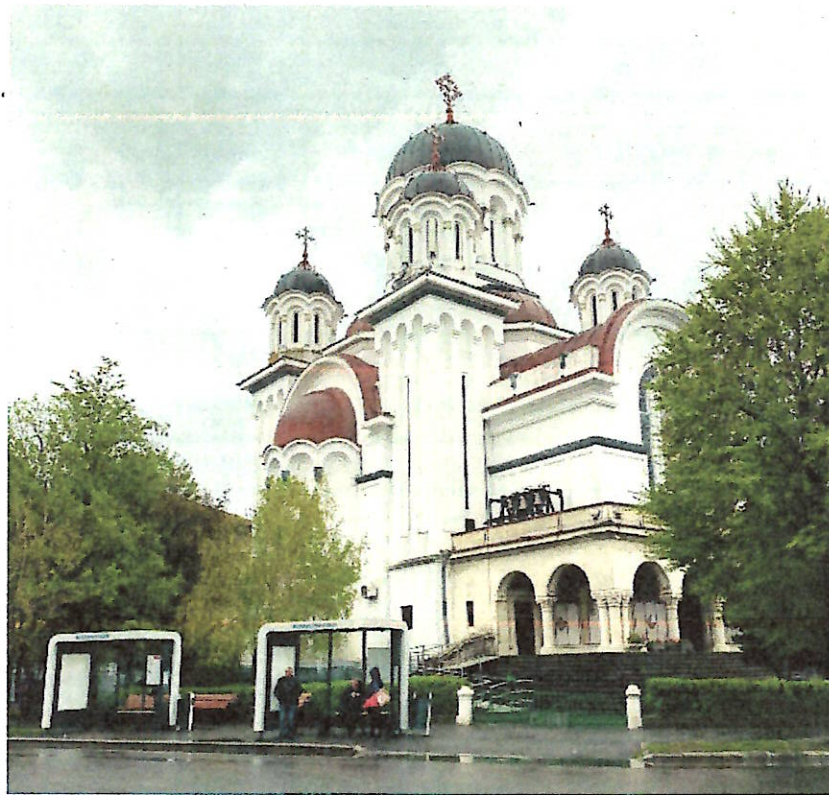
Vedere dinspre latura nord-vestică a Bisericii
