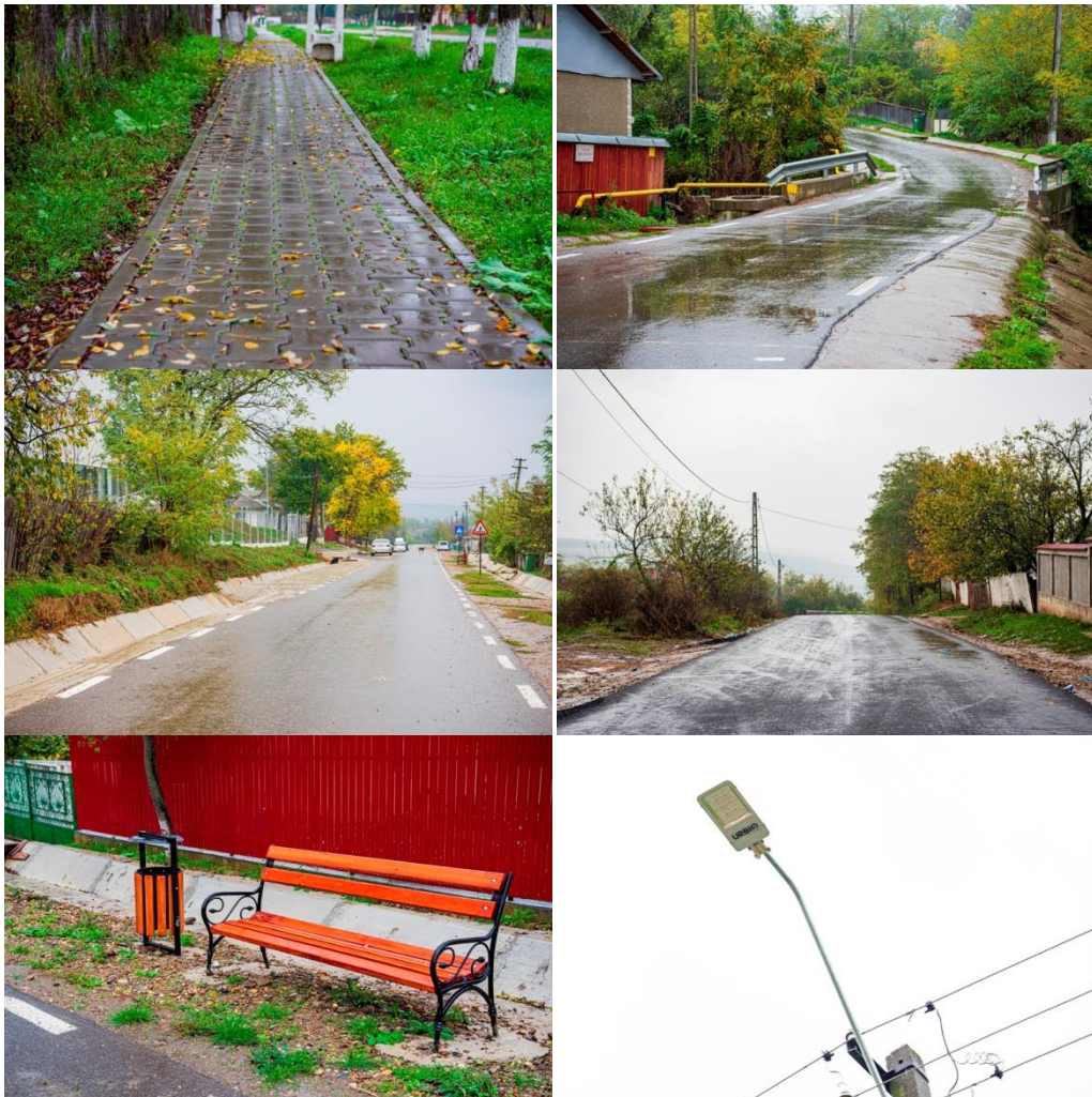
Infrastructură locală și utilități publice în comuna Lipovăț
