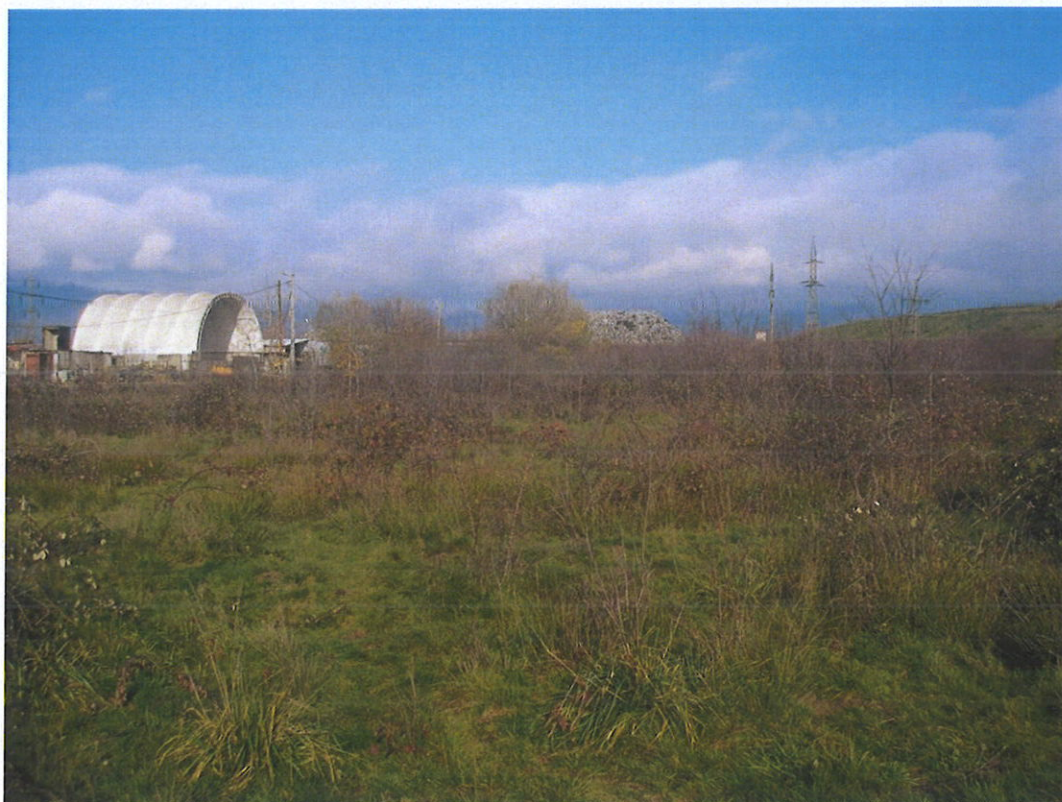
Vedere teren de pe latura estica
