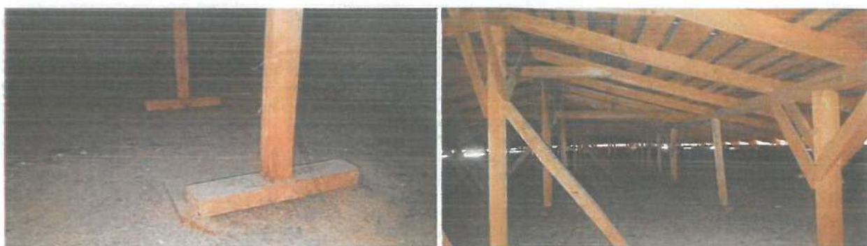
Elemente de acoperis subdimensionate, netratate, si rezemate direct pe termo-hidroizolatie existenta
