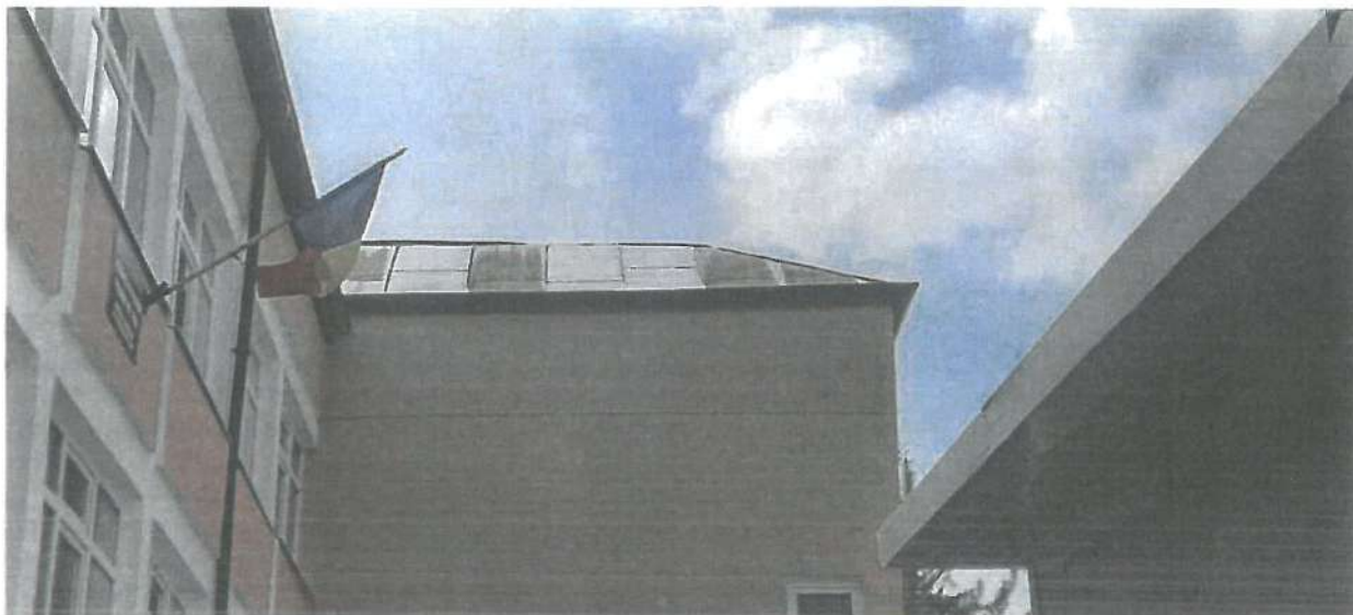
Acoperis - tip sarpanta de lemn cu invelitoare de tabla
