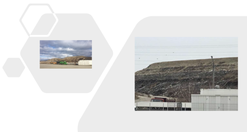
Figura 3-15: Celula 2 a depozitului conform de la Aninoasa
