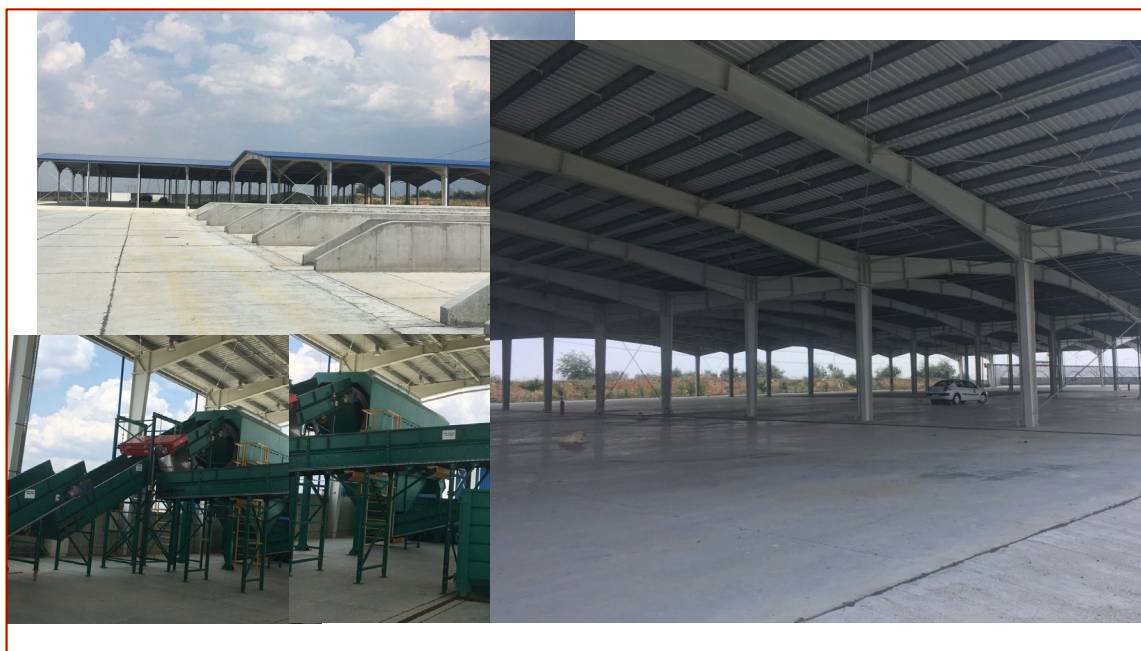
Figura 4-11: Instalație TMB Ovidiu
