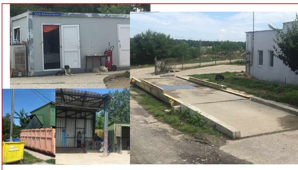
Figura 4-8: Echipamente tehnologice stație de sortare Cernavodă
