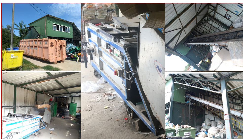
Figura 4-7: Infrastructura stației de sortare Cernavodă
