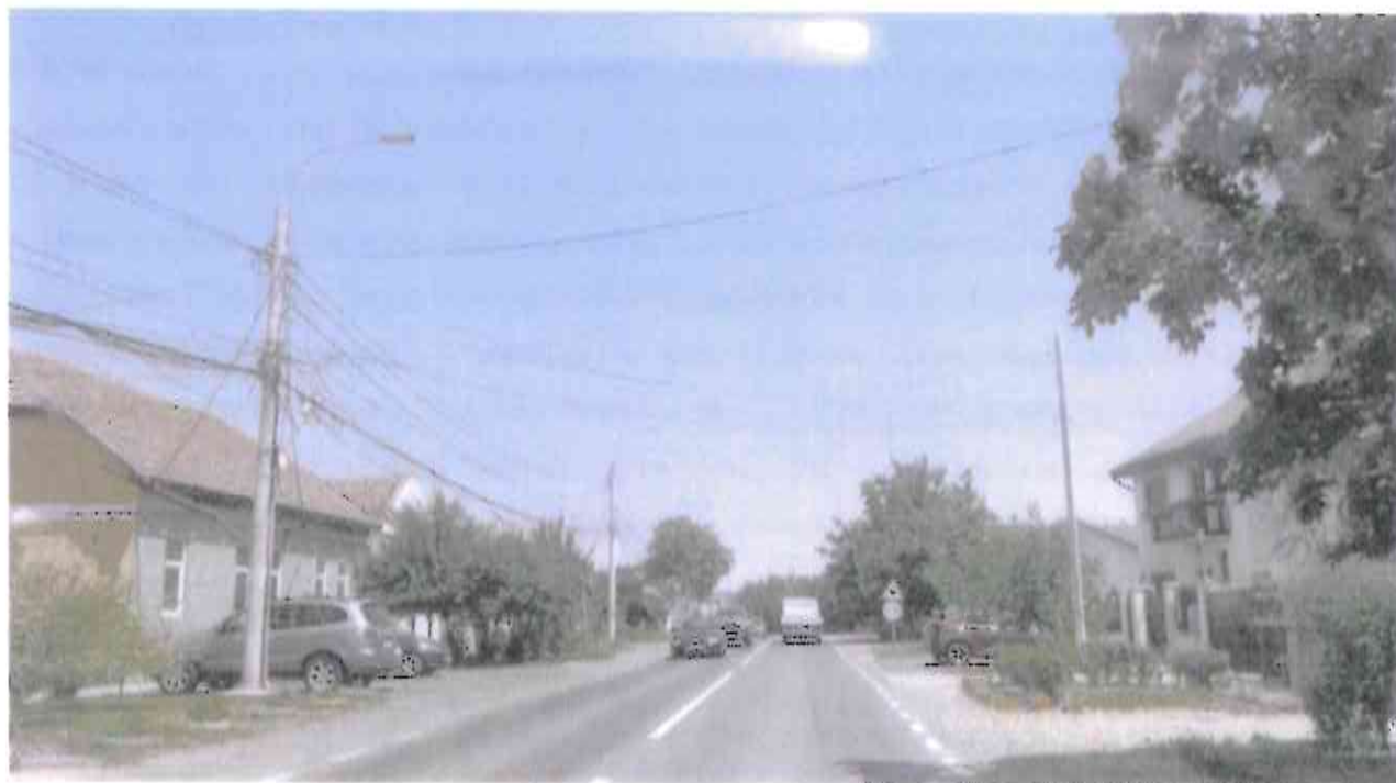
Foto 2. Accese proprietăți neamenajate. Lipsă șanțuri
