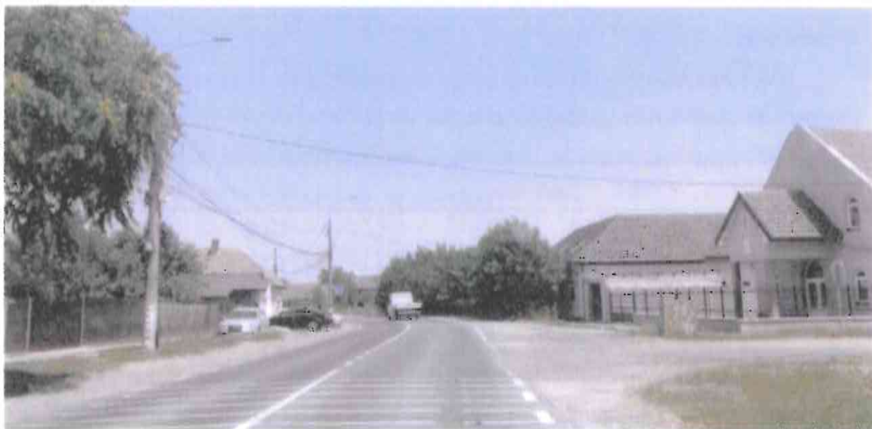
Foto 3. Drum lateral fără podeț transversal.
