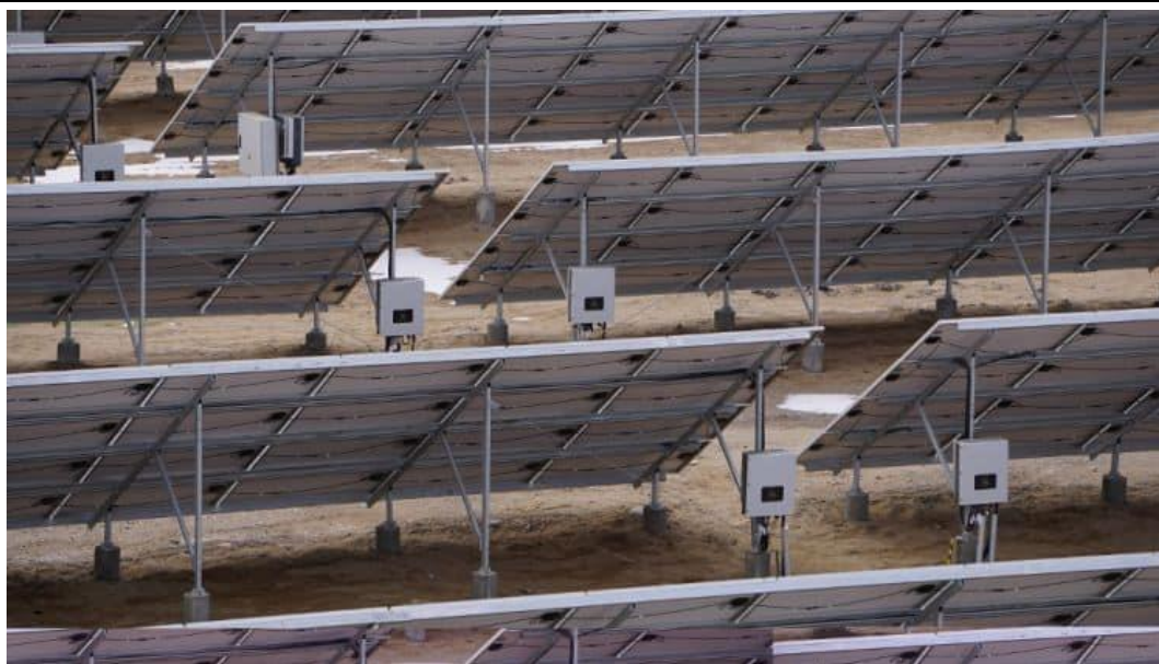
Montajul invertoarelor pe sol
