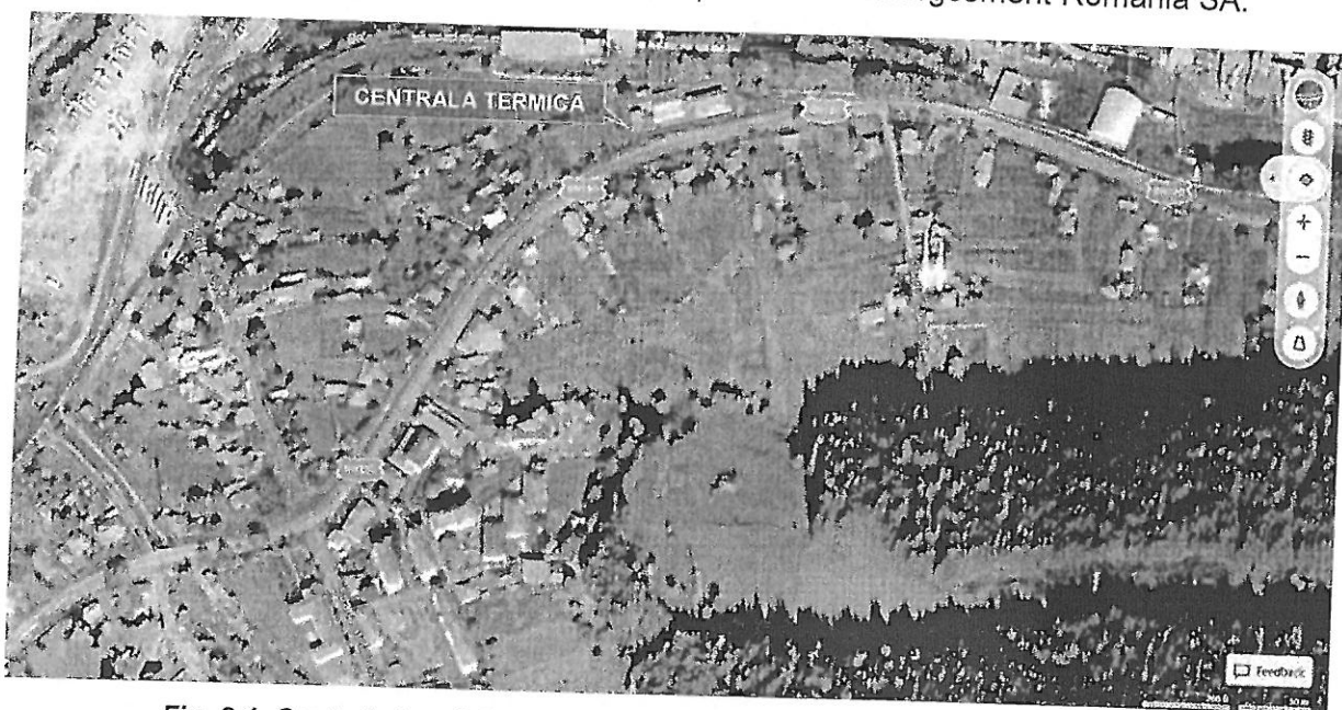
Fig. 2.1. Centrala termică Termo Serv Com Tașca SRL – localizare din satelit
