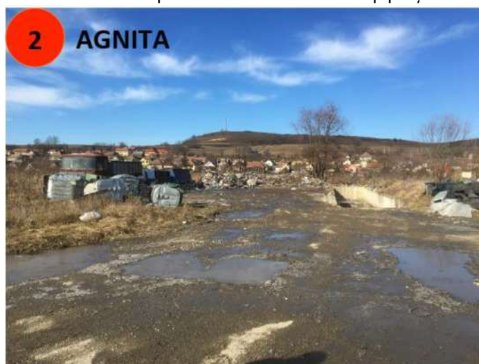
Figură 2-10 - Stația de transfer Agnita
