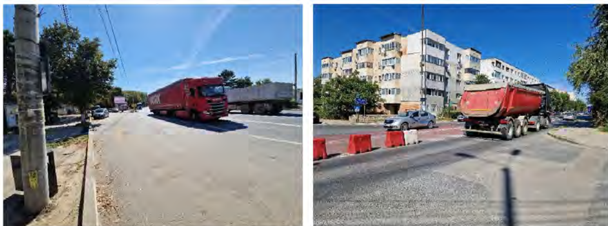
Figura 2.47. Traversarea zonelor de locuințe/ funcțiuni socio-economice de vehiculele grele de marfă - Eforie Sud (stânga), Eforie Nord (dreapta).
