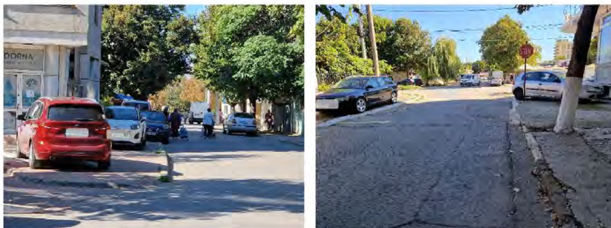
Figura 2.53. Trotuare acaparate de autovehicule parcate (exemplificare).
