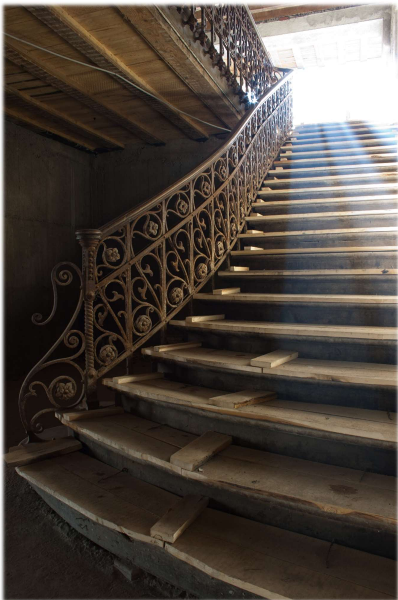
Fig. nr. 19 – Scara interioara, Sursa: https://conacppcarp.files.wordpress.com/
